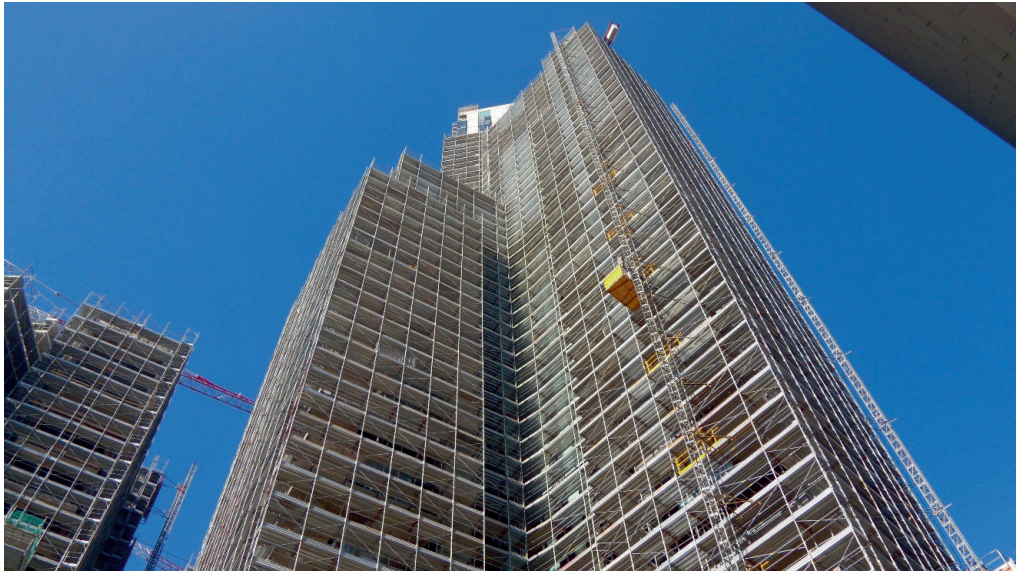
Figura 4.1.1-1: Ponteggio di facciata (Fonte: Eurotempo)
