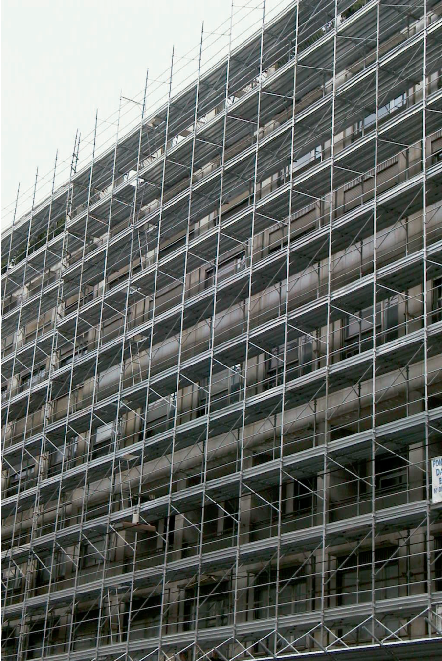
Figura 1.1: Ponteggio di facciata (Fonte: Eurotempo)
