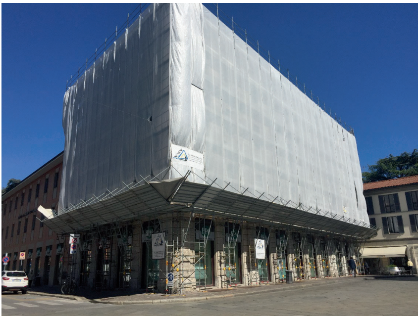
Figura 5.9-1: Ponteggio rivestito con teli (Fonte: Eurotempo)
