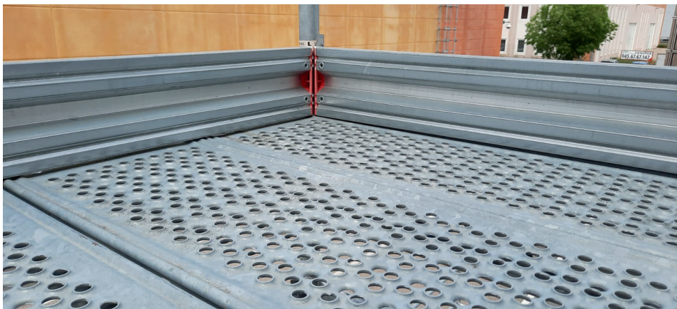
Figura 5.8-3: Fermapiede – Particolare soluzione d'angolo (Fonte: Lahyer)
